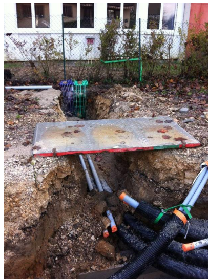
Tranchées diverses avec les tuyaux du réseau de chaleur sur la photo centrale
