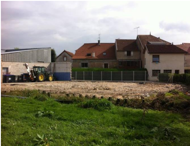
Plate-forme après démolition des ateliers municipaux
