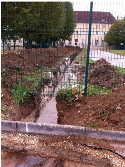
Tranchées diverses avec les tuyaux du réseau de chaleur sur la photo centrale
