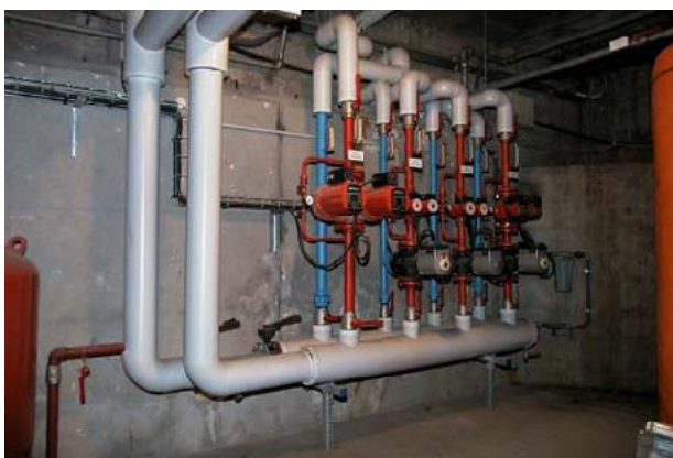
Circuits secondaires de la chaufferie n°2
