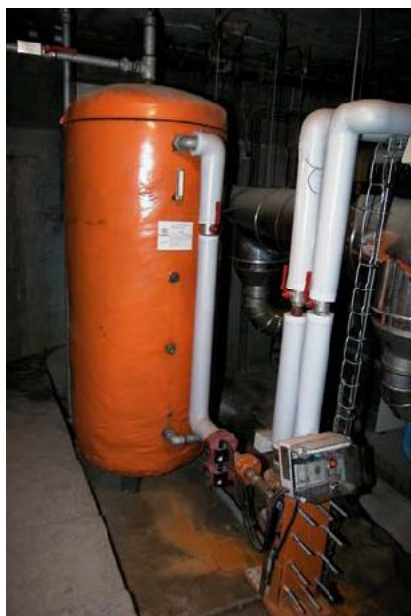
Ballon d'eau chaude sanitaire dans la chaufferie n°2
