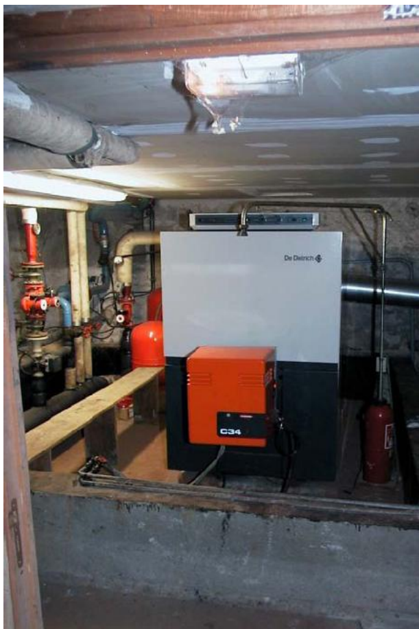
Chaudière et circuit hydraulique
