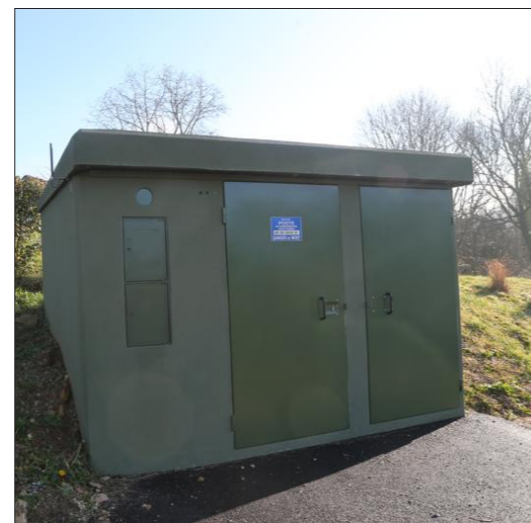
... par un bâtiment de volume comparable à un abribus comme ici à Charriez. Photo ER/Bruno GRANDJEAN
