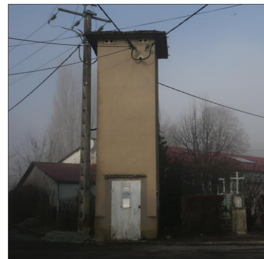
Les travaux vont commencer prochainement à Velle-le-Châtel. Le poste de transformation sera détruit et remplacé... Photo ER/Bruno GRANDJEAN
