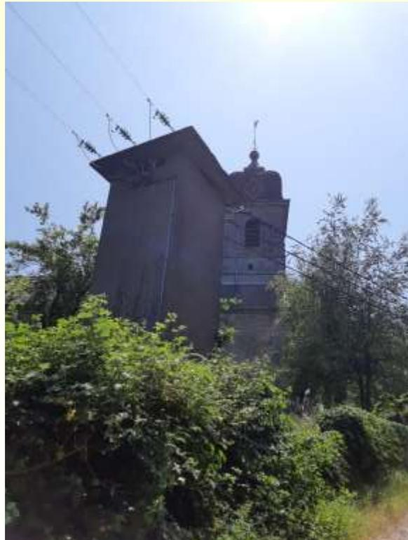
⚡ Construits jusque dans les années 1960, avant la technologie souterraine, les postes cabines hautes ou tours, mesurent de 6 et 10 mètres.
