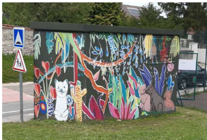
Le poste de transformation après le travail des élèves
