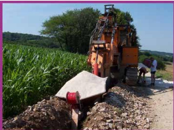
Pose mécanisée d'un câble HTA 20 kV
