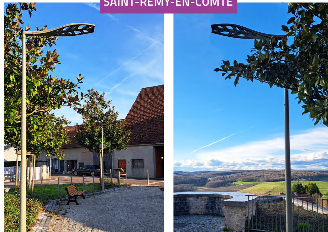
Mise en lumière d'un belvédère rénové - le 26/03/2025
