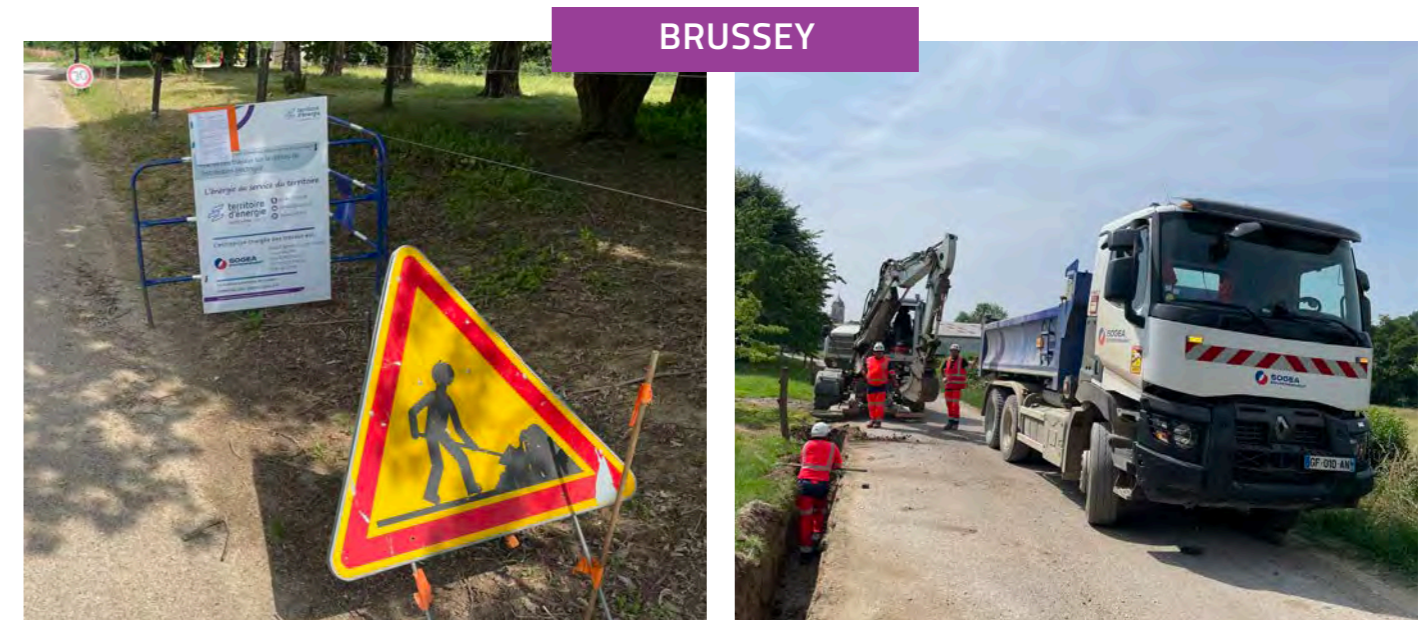
Travaux d'extension souterraine du réseau d'électricité au lieu-dit Les Vignottes - le 12/06/2025
